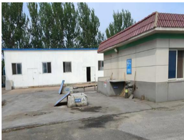
项目综合污水处理站
