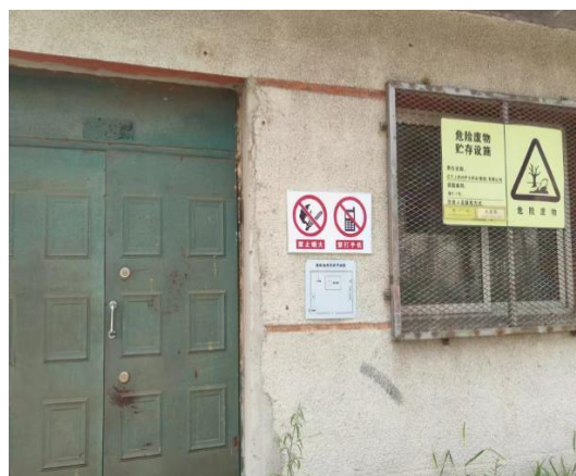
危险废物暂存间
