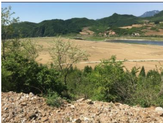
废石堆场边坡
