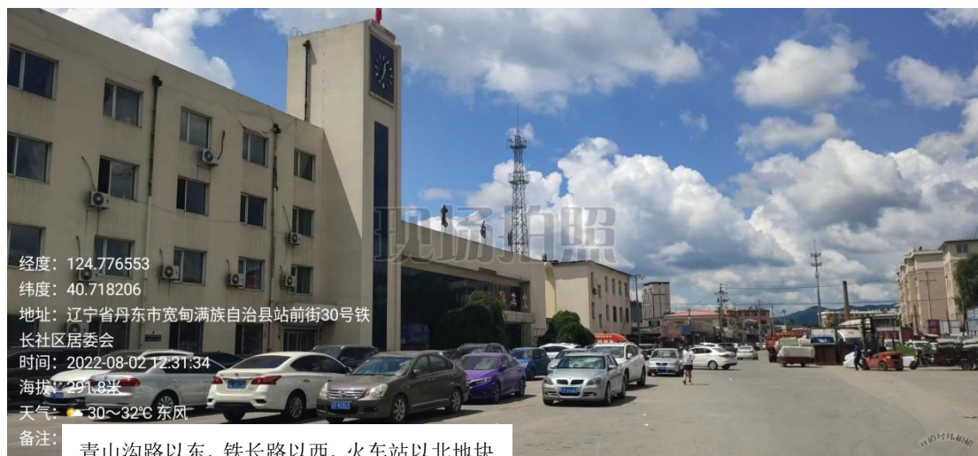
图 3-27 调查地块南侧宽甸火车站
